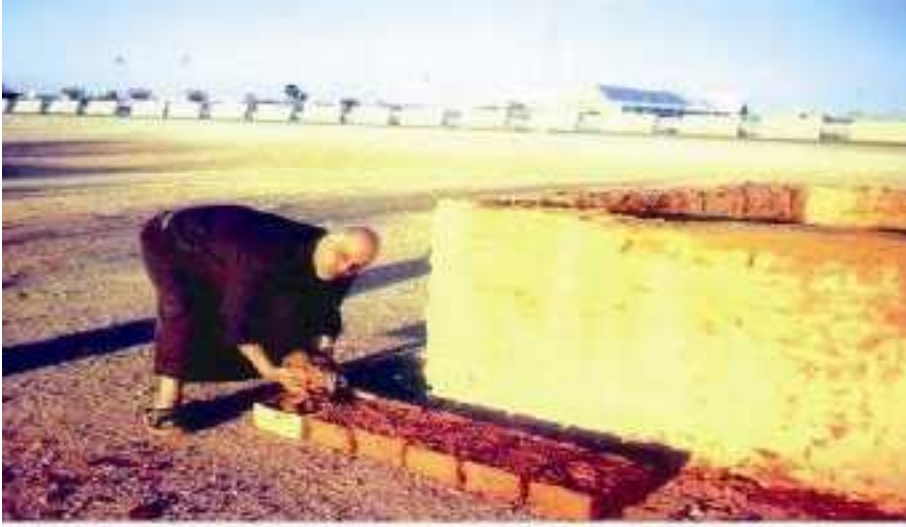
علي الحمدان وحرفة عمل الطوب الطيني والبناء
